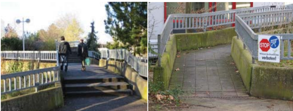
Abb. 10: Zugang Brücke aus westlicher Richtung (links) und dazugehörige Rampe (rechts)
