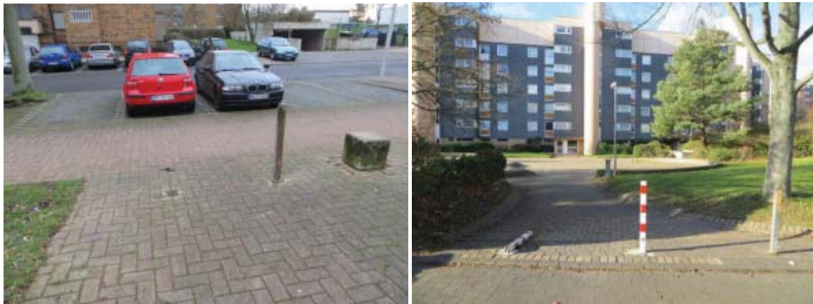
Abb. 52: Beispiele von beschädigten oder entfernten Absperrungen
