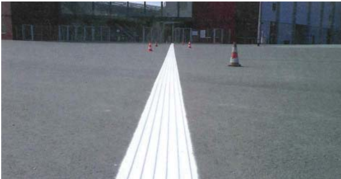
Abb. 54: Kostengünstige Auftragung von Blindenleitstreifen mithilfe von Strukturmarkierungen
