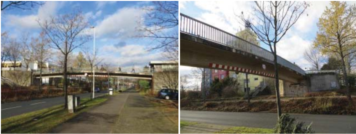
Abb. 9: Fußgängerbrücke Agnetendorfer Straße
