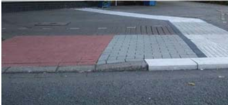
Abb. 43: Querungsstelle mit differenzierter Bordhöhe
